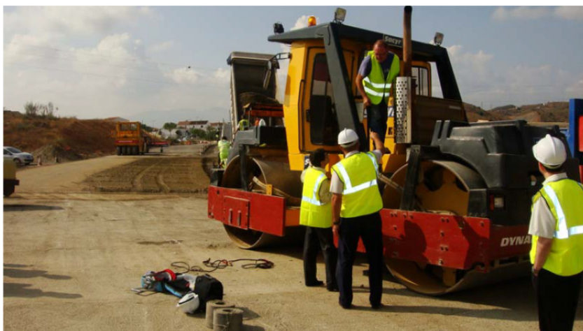
Figura 4: Pruebas del sistema en una obra real.
